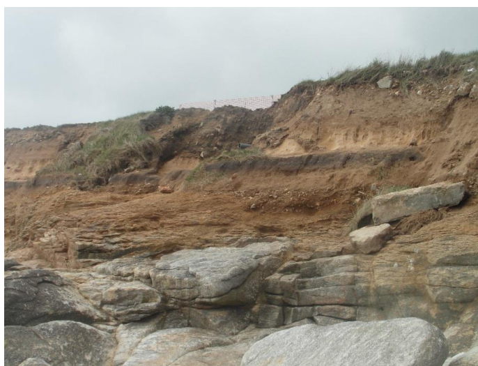
Falaise érodée et glissement de terrain lié à la force des vagues (plage de Trégana) – photo avril 2014
